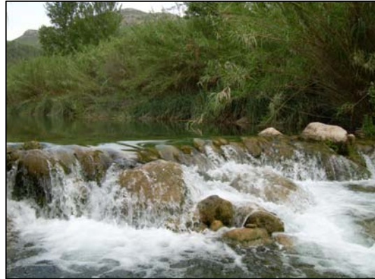
Foto 2: La represa nº 12 de Montanejos, construida para el baño, representa una barrera infranqueable
