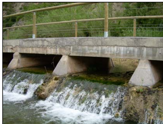
Foto 3: Estructura infranqueable, que sirve de refuerzo en uno de los puentes de Montanejos
