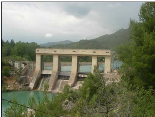
Foto 1: Presa de Ribesalbes, infraestructura infranqueable para la fauna ictícola
